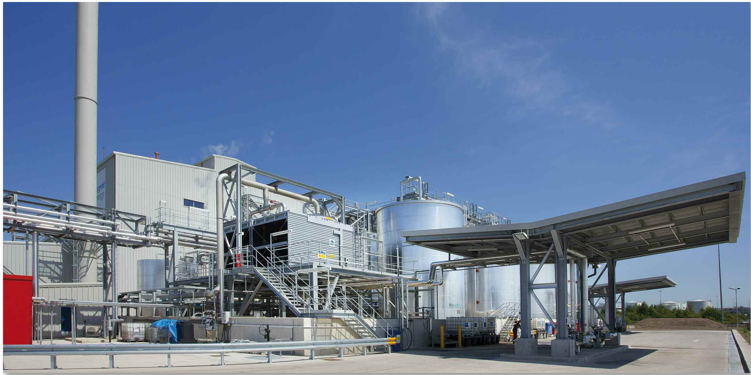
Biodiesel-Raffinerie der Firma Argent Energy in Großbritannien
