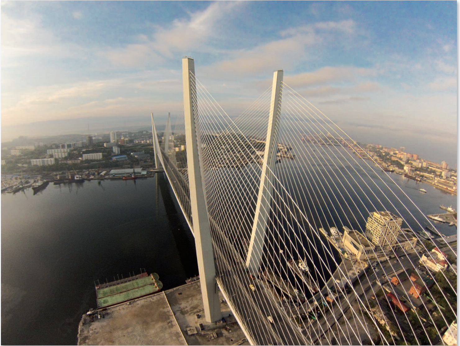
Blick von der Zolotoy-Brücke auf Wladiwostok. Die Schrägseilbrücke wurde im Juli 2012 anlässlich des asiatisch-pazifischen Wirtschaftsgipfels eröffnet.
